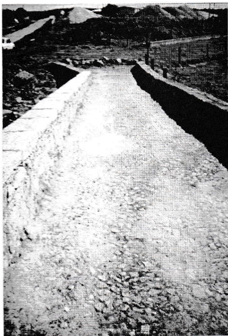
Puente de la Dehesa recien limpiado
