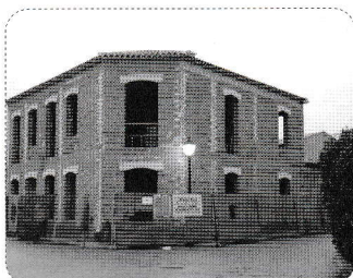
Casa que se construye en el solar en el que hace esquina con la calle Madrid con el callejón del Matadero esquina muy bien achaflanada
