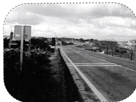
Uno de los trozos de Circunvalación del pueblo sin calle ni acerado
