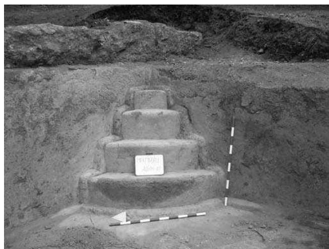
Figura 2: Escalera de acceso a la natatio del edificio termal
